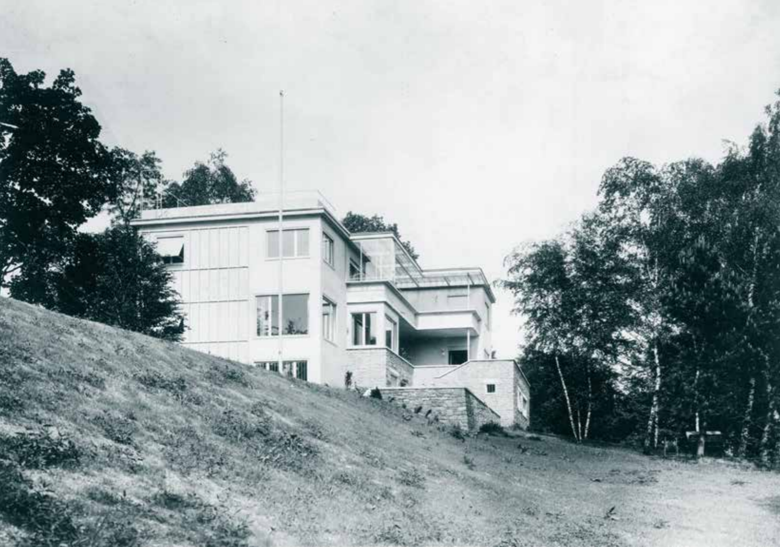
Aussenansichten von Westen um 1935. Noch mit dem ursprünglichen Terrassen- aufgang und noch ohne grosse Bäume.
